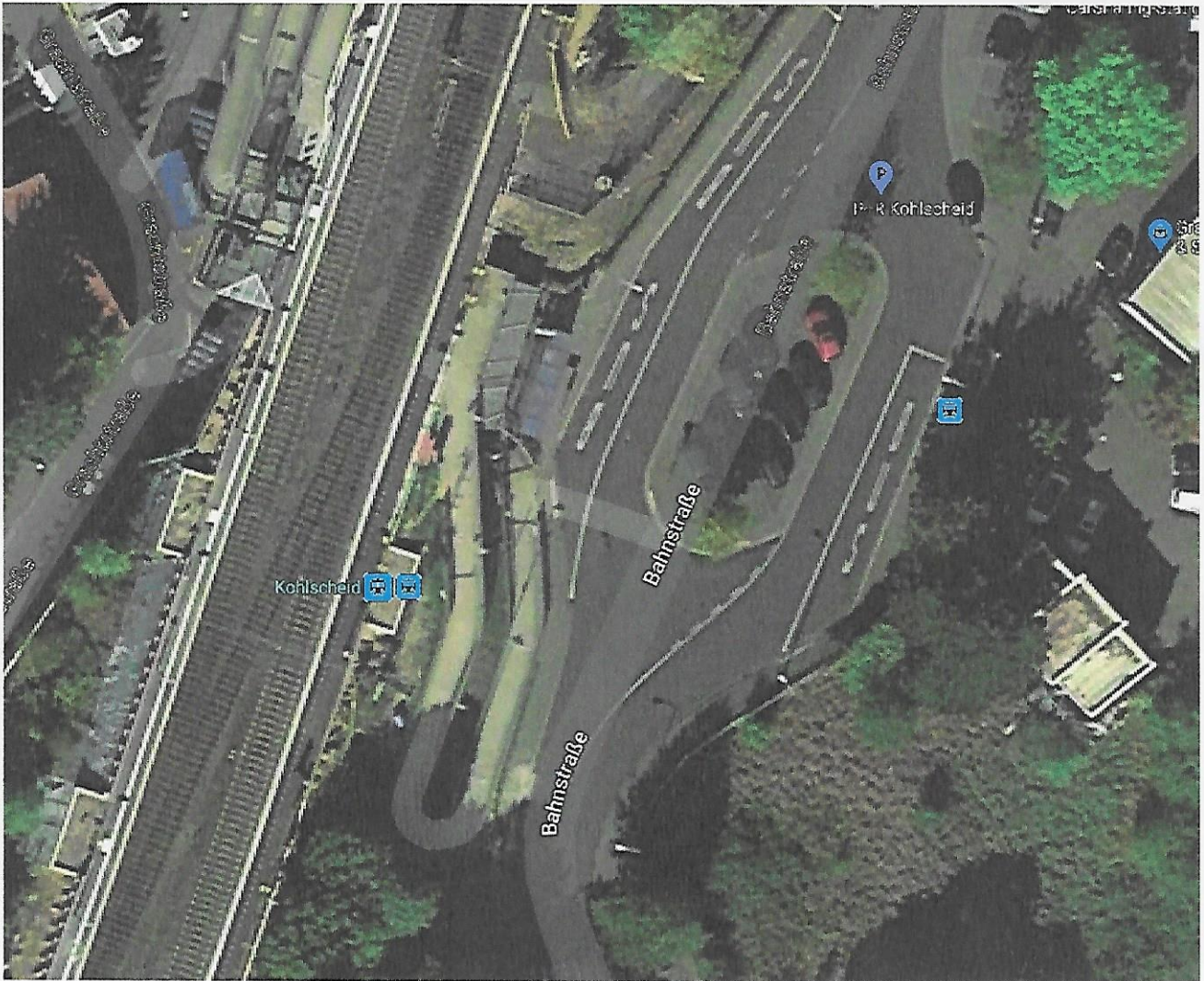
Bild: Serpentinweg vom und zum östlichen Bahngleis in Herzogenrath-Kohlscheid (Bauphase). Die nördliche Rampe ist durch den Umbau versperrt und nicht mehr zugänglich. Eine Treppe wie auf der Westseite, wo ein sehr viel größerer Höhenunterschied besteht, existiert hier nicht.
